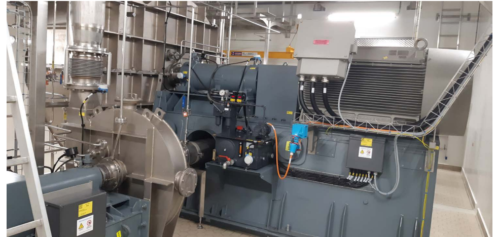
Ventilator en systeem onderdeel van een MVR-installatie
