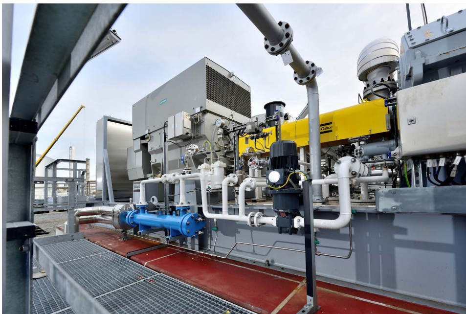
Stoomrecompressor Dow Terneuzen
